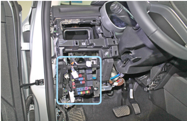
Фото 3.20. Местоположение монтажного блока предохранителей
