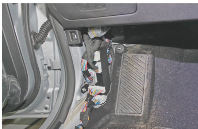
Фото 1.9. Накладка левой кик-панели снята
