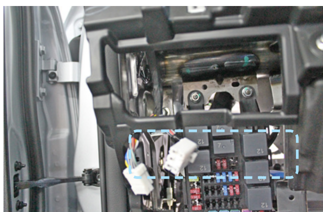
Фото 2.10. Пример расположения центрального блока охранно-телематического комплекса
