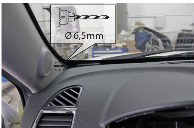
Фото 2.2. Место установки светодиода
