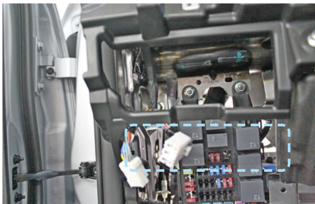
Фото 2.9. Пример расположения центрального блока охранно-телематического комплекса
